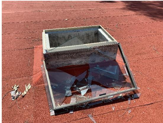
*Ilustración 29 Mantenimiento a domos de Policarbonato*
