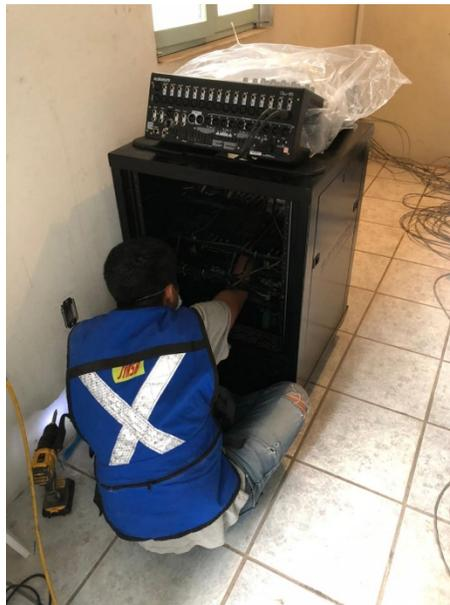
*Ilustración 42 Instalación de Equipo de Audio*
