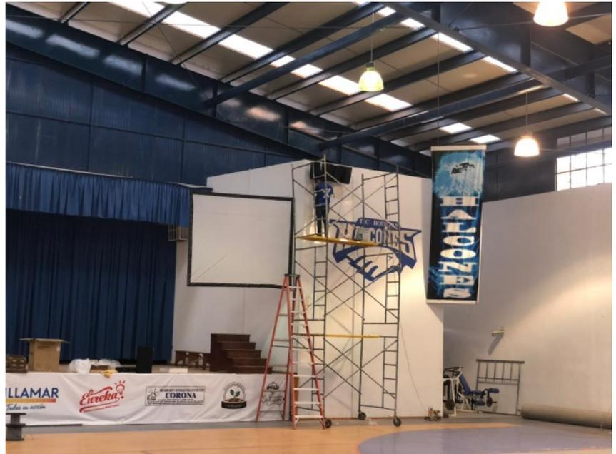
*Ilustración 41 instalación de Equipo de Audio en el Gimnasio Auditorio*
