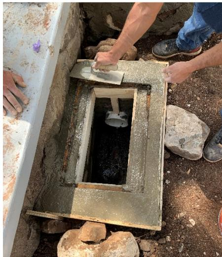
*Ilustración 28 Reparación de ductos de drenaje*
